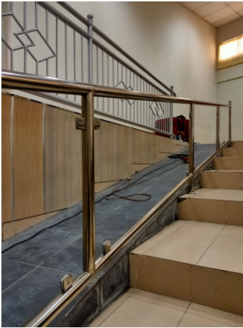
Ramp Difabel Gedung Teatrikal UIN Jogja
